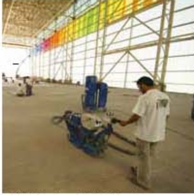
Sabiha Gökçen Havaalanı Uçak Bekleme Hangarı
